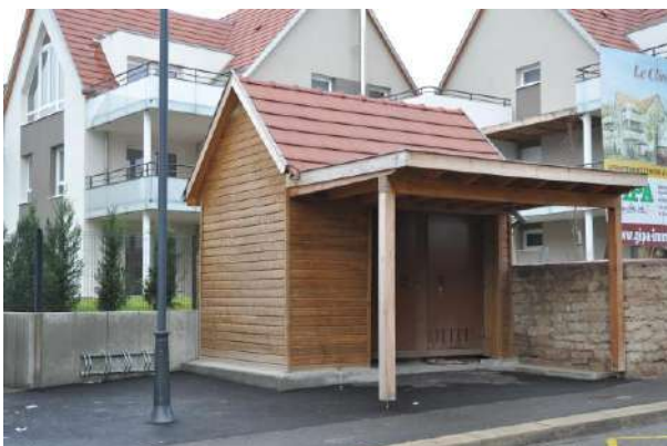
Aménagement d'un abri-bus
