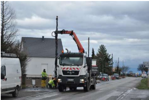
Achèvement de l'aménagement de l'éclairage public route des Romains et rue Principale
