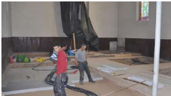
Dépose des lambourdes et du revêtement existants, et pose d'une dalle béton
