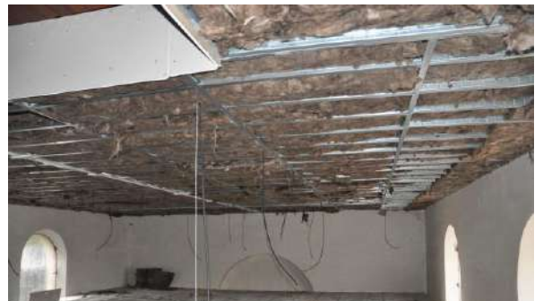
Isolation et pose d'un faux-plafond « voielactée » à l'église
