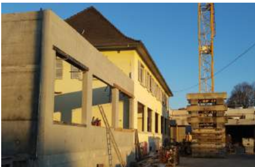
Construction d'une cinquième salle de classe à l'avant du bâtiment existant
