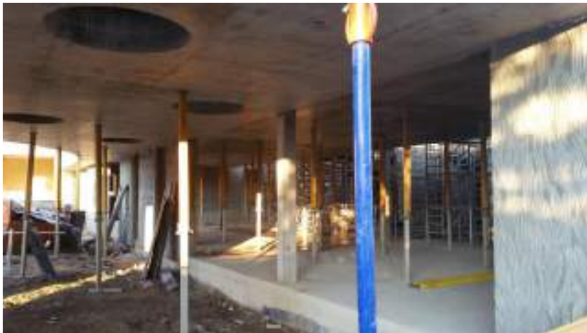
Travaux de gros-œuvre au niveau du préau
