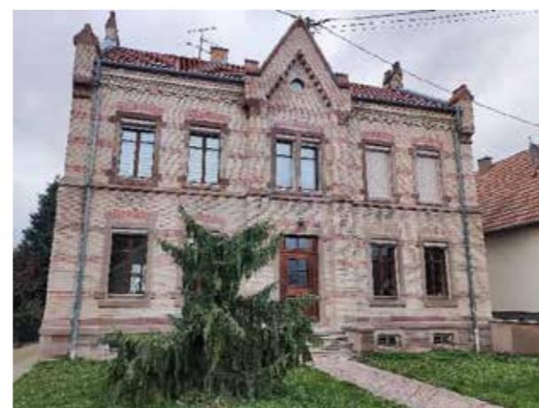
Ravalement de façade au presbytère et isolation intérieure
