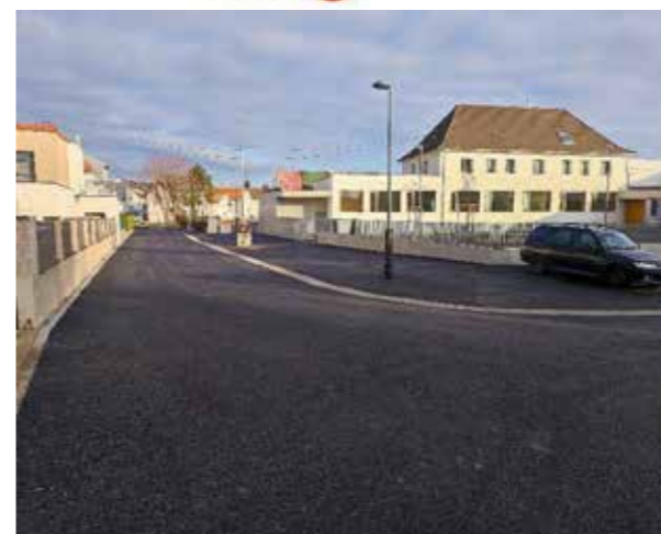
Aménagement de la voirie et sécurisation des abords de l'école.
