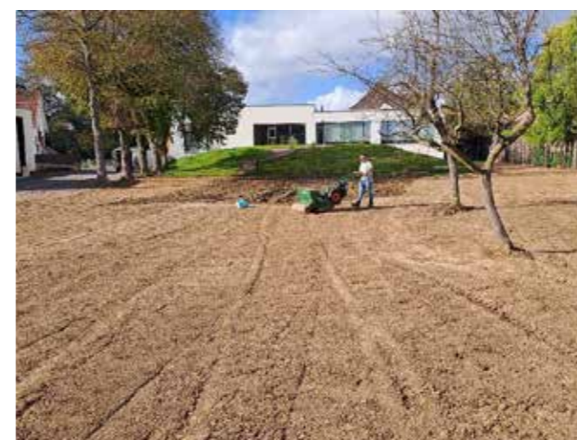
Terrassement et engazonnement du terrain derrière l'école
