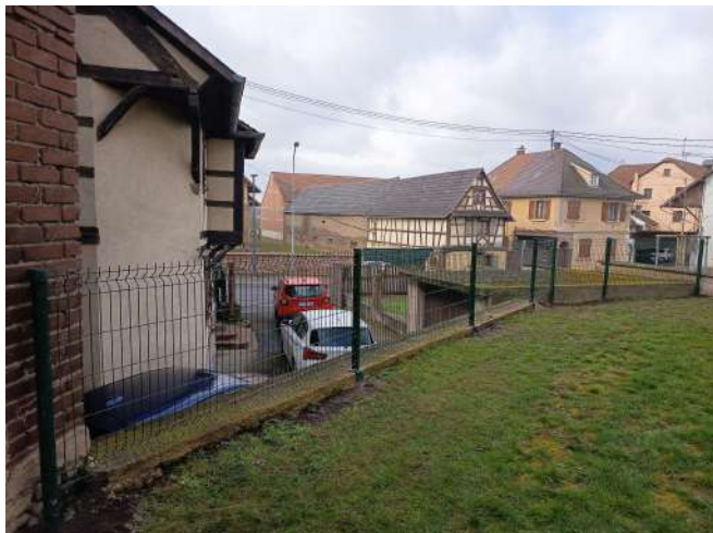
Mise en place d'une clôture rigide à l'église - Travaux réalisés en régie.
