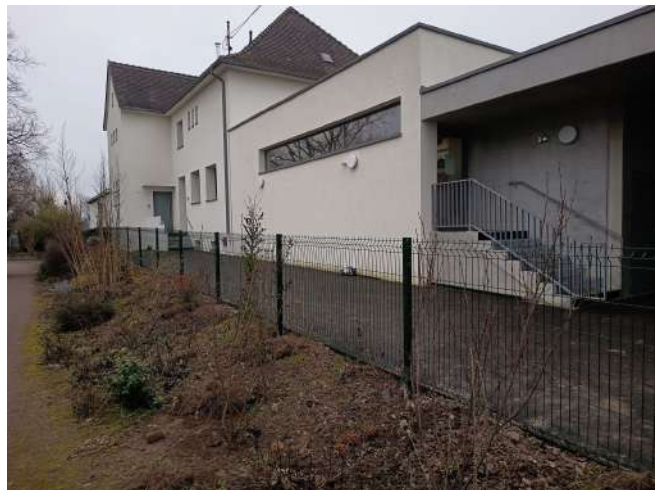
Mise en place d'une clôture rigide à l'école - Travaux réalisés en régie.
