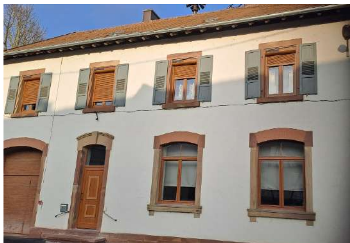
Remplacement des fenêtres et mise en place de volets roulants du logement salle communale.
