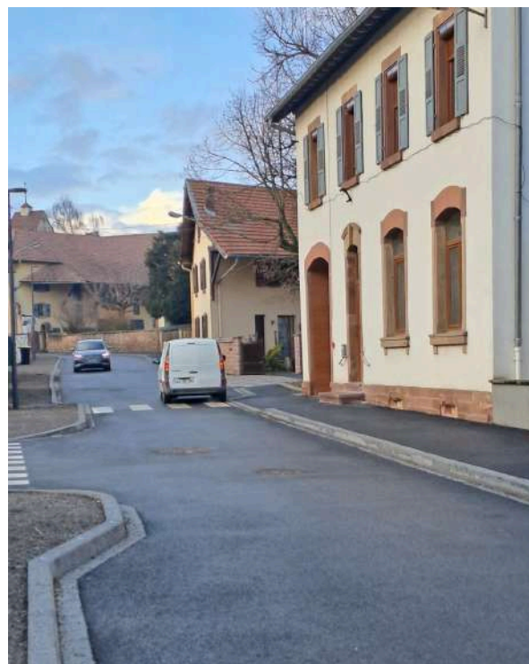
Aménagement voirie rue Principale.
